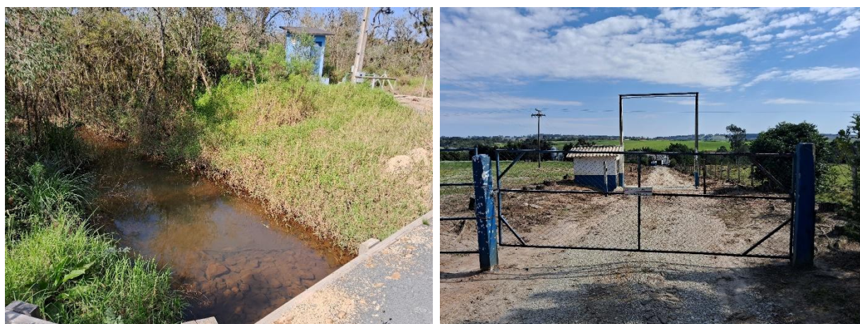
FIGURA 37 – CONDIÇÕES SANITÁRIAS NA ÁREA 2 DA CRQ VEM
