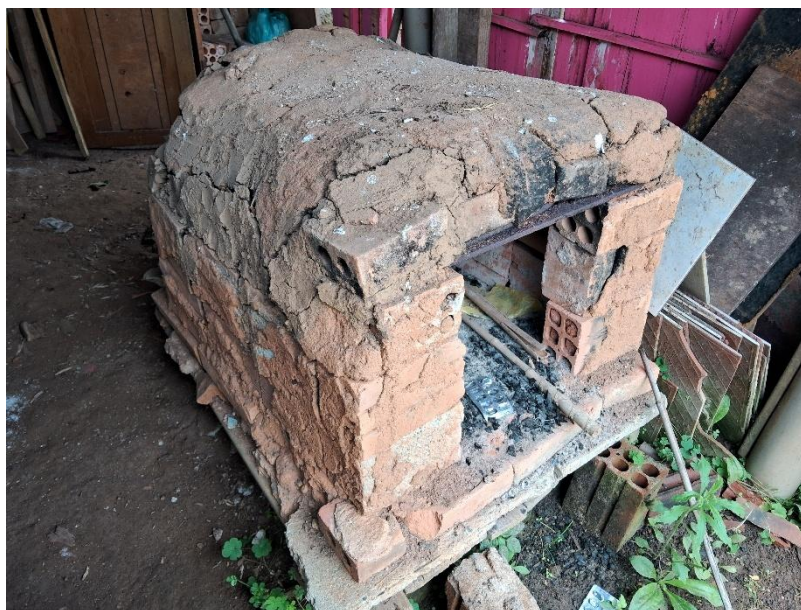
FIGURA 43 – FORNO DE TIJOLOS REVESTIDO COM BARRO
