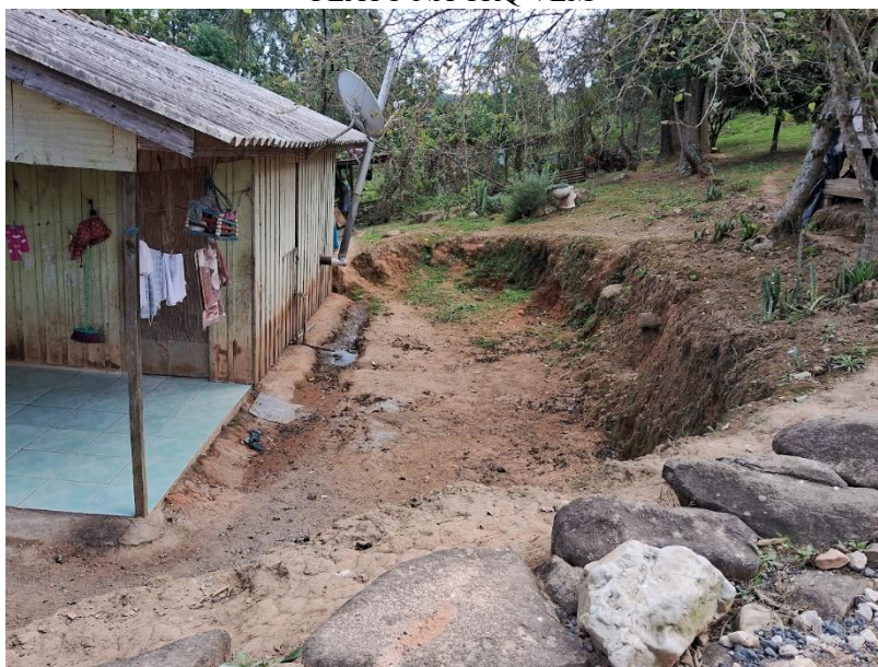
FIGURA 25 – DOMICÍLIO CONSTRUÍDO EM DECLIVE APÓS CORTE DA ENCOSTA E CRIAÇÃO DE PLATÔ NA CRQ VEM
